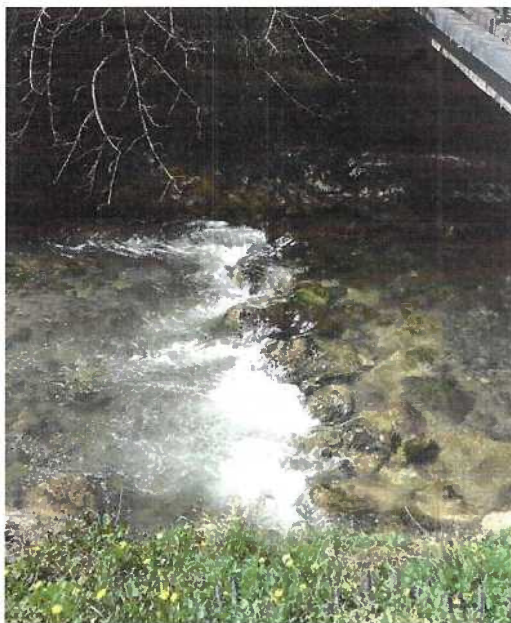
Slika 5: Stopenjski prag s tolmunom (Sevnična v Sevnici – Šmarje).
